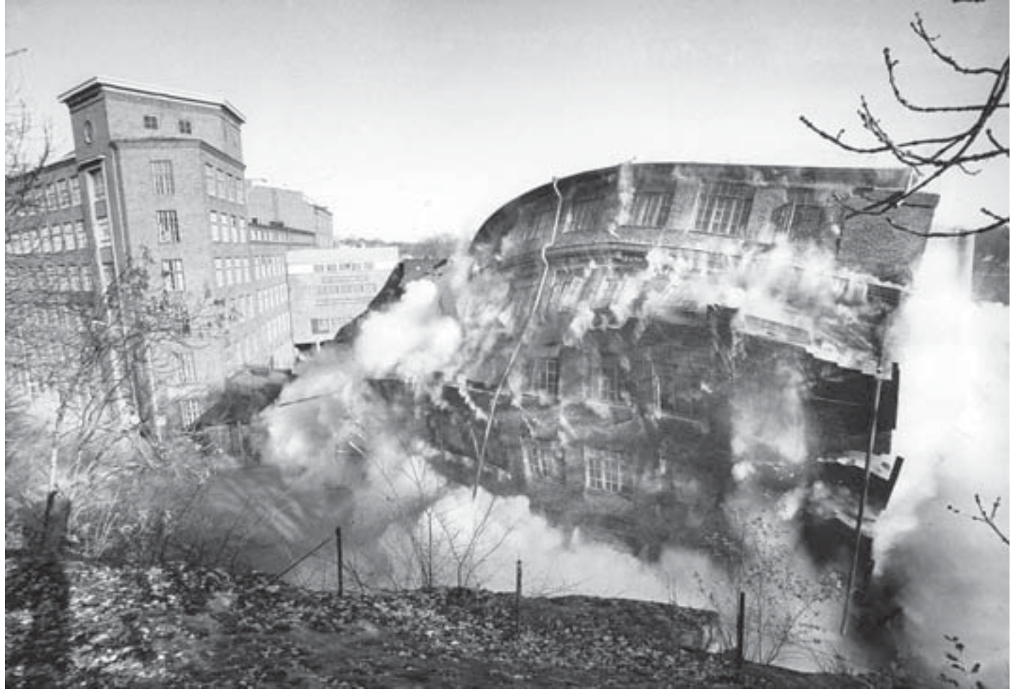
Turun vanha verkatehdas räjäytettiin maan tasalle 18. lokakuuta 1986. Alueelle alettiin rakentaa Tervatoria, aikansa arvoaluetta.
